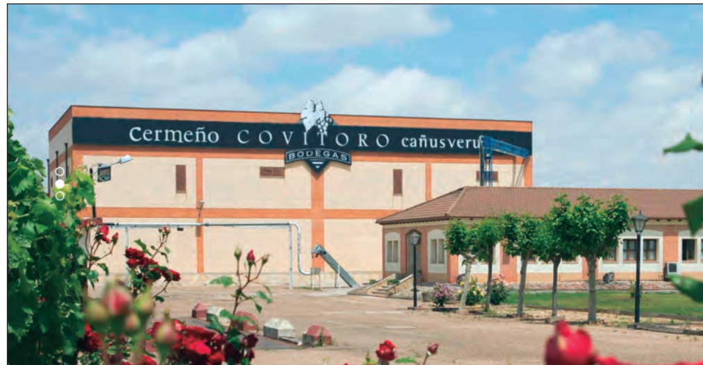
Instalaciones de Covitoro en Toro (Zamora).
