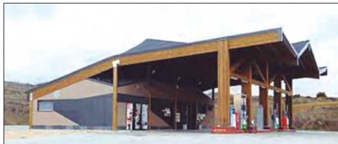
La instalación fotovoltaica de Ventas de Armentia genera un efecto depurativo similar a la fotosíntesis de 1.730 árboles.
