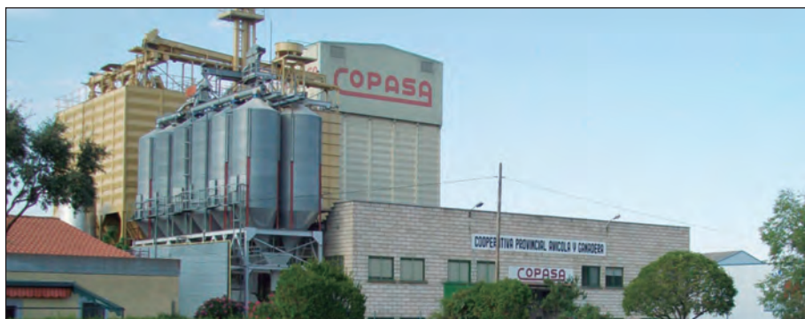
Instalaciones de Copasa en Salamanca.
